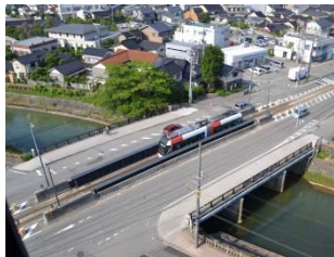
都心部の橋梁 八田橋（1969）
