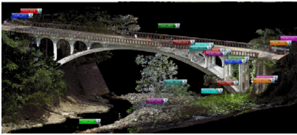
写真-4 3Dレーザースキャナーによる画像
