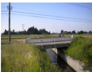
都市外縁部の橋梁
