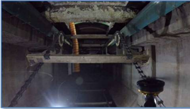
写真-1 上部：管廊での自動飛行状況 下部：沈殿池内での飛行時取得画像
