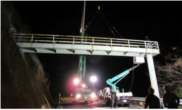
図3 使用されていない歩道橋の撤去
