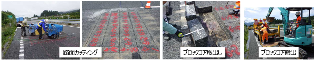
図4 路面開削の状況
