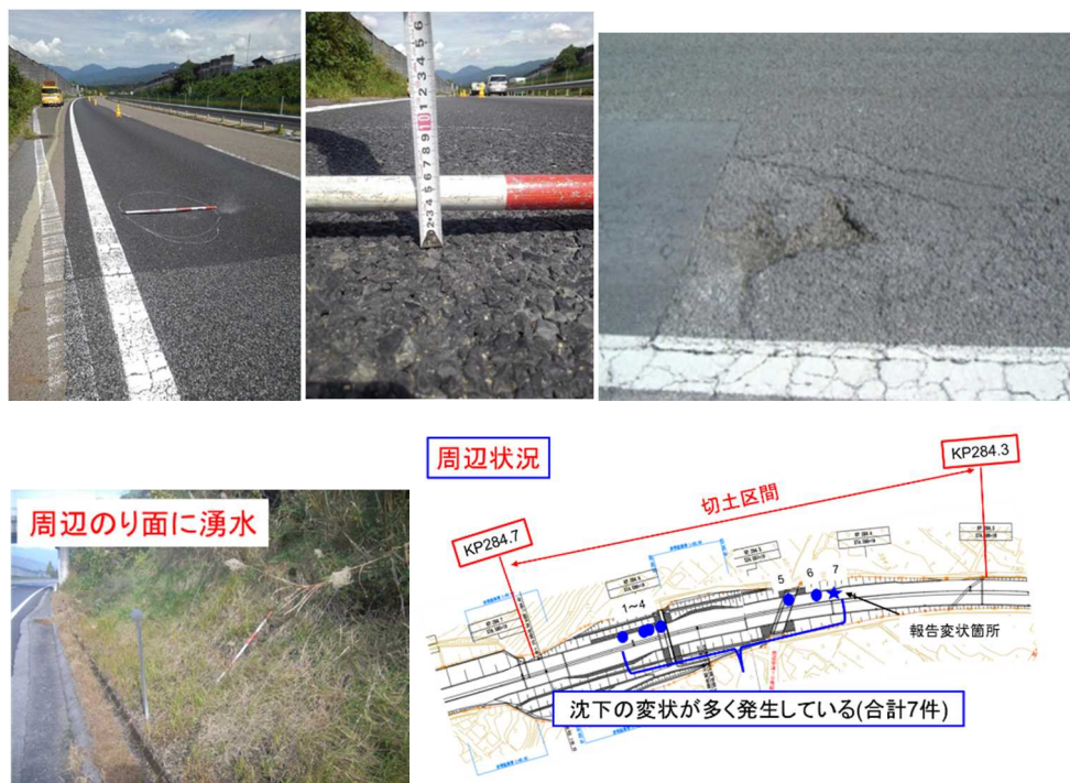
図-3 開削前の路面状況(中央自動車道上り線飯田保管内)
