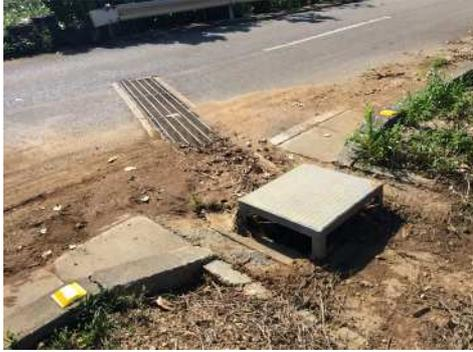
土砂堆積による排水柵のつまりに起因する冠水発生個所において、土砂詰まりが発生しにくい構造の柵に改良。土砂流入の改善が困難な場所であるため、土砂も流入させることで、柵のつまりを抑制する考え方に変更。
